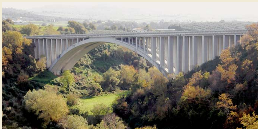
Il ponte Tenza oggetto delle analisi
